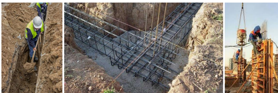
Figure 1. Différentes missions et tâches dans la réalisation des projets. De gauche à droite, fouilles, fondations, et coulage des poteaux.
