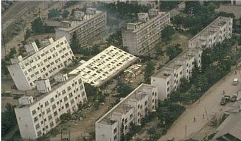
Figure 23 : Enfoncement et basculement des bâtiments à cause du phénomène de liquéfaction du sol survenu à Nigata (Japon) en 1964.
