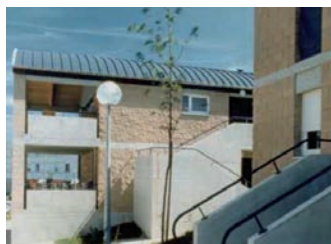
Photo des terrasses du plot intermédiaire
