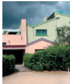
Photo d'extérieur : emboitement des maisons
