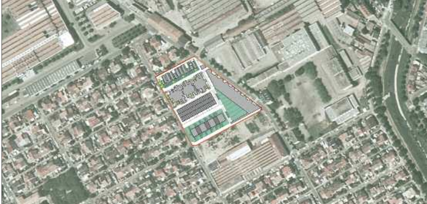
Une opération poursuivant la trame viaire existante.
