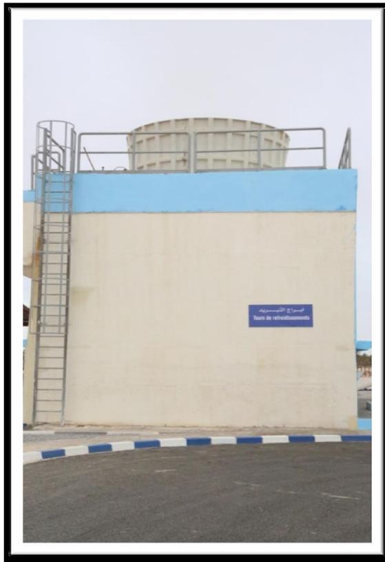
Fig. V .7 : les tours de refroidissement de la station.
