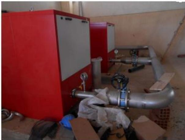
***Fig. V 11 : Suppresseur air de la station***
