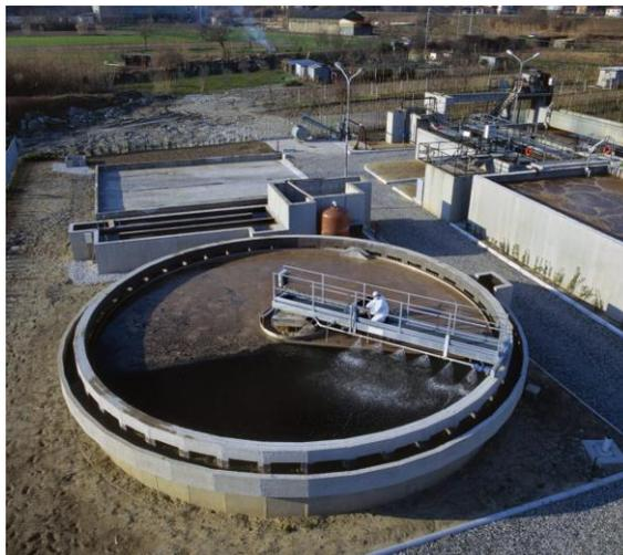
**Figure. I.6 :** Bassin décanteur
