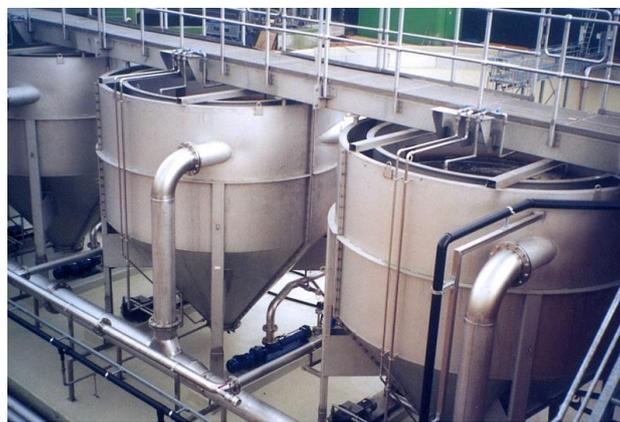
**Figure I.4.** Dessableur-dégraisseur circulaire
