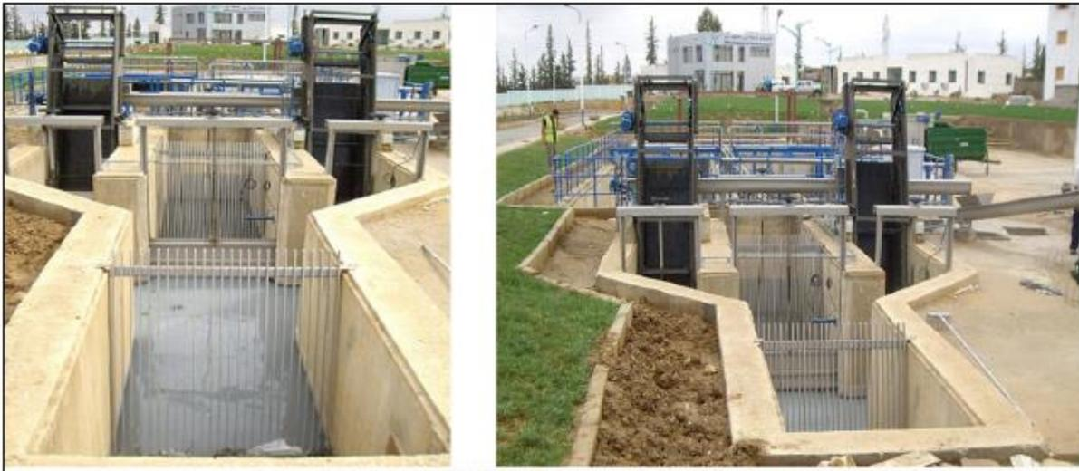
**Figure I.1.** Opération de dégrillage.
