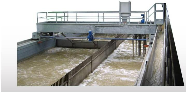
**Figure I.5.** Dessableur-dégraisseur rectangulaire
