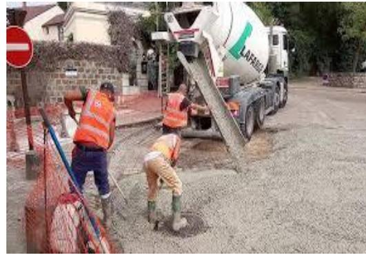
7. le camion toupie (malaxeur) est un engin de transport des bétons de l'unité de confection (fabrication) au lieu d'étalement et de mise en œuvre, ayant pour rôle de maintenir l'ouvrabilité du béton jusqu'à sa destination finale.
