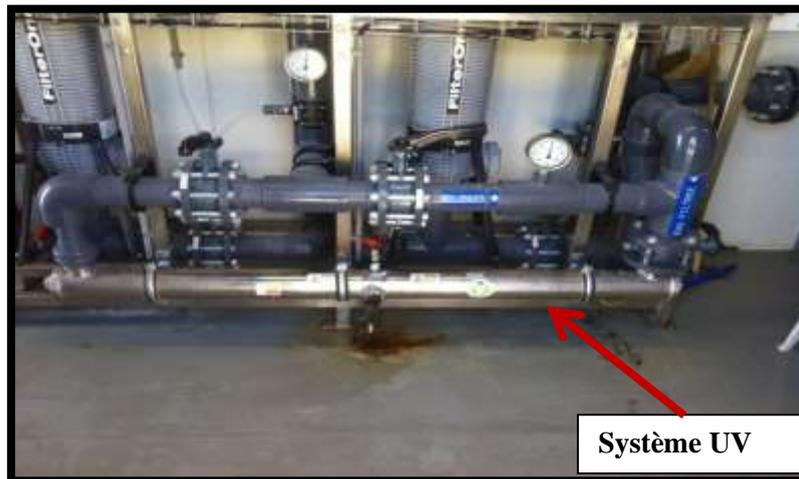
Figure 3: Désinfection des eaux souterraines par UV dans la station de déminéralisation des eaux souterraines dans le Complexe touristique ‘ La Gazelle d’Or (El-Oued-Algérie)’
