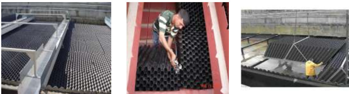
Figure 5: Décanteur à tubes fortement inclinés
