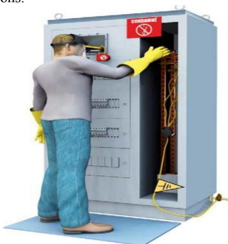
**Figure 3.56** Mise à la terre et en court-circuit
