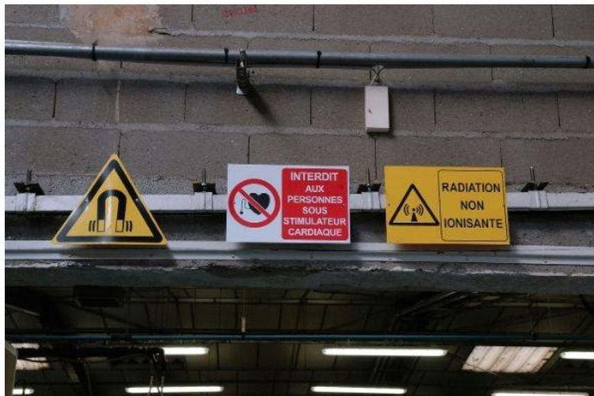
**Figure 3.86** Signalisation globale champs électromagnétiques avec interdiction de l'accès aux porteurs d'implants actifs doc INRS
