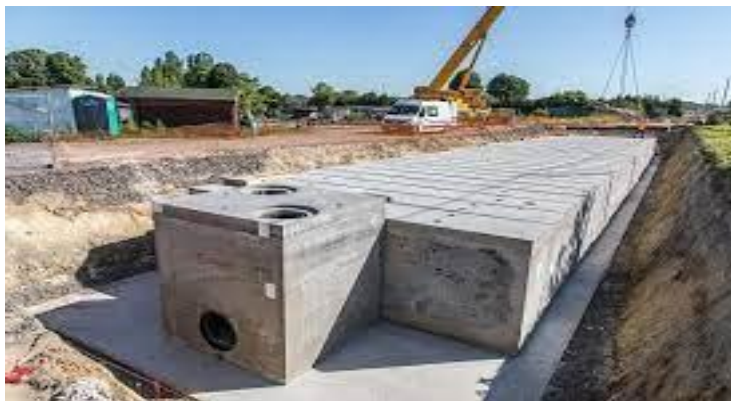
Figure 8 : ouvrages de stockage et de rétention.
