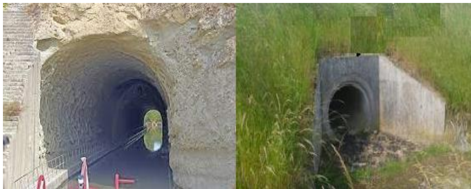
Figure 1 : Exemples d'assainissement transversal.
