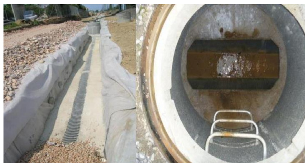
Figure 4 : Collecteur Drainant en cours de la réalisation
