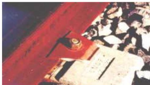
*(Nabla fastening system (Système d'attache de Nabla))*
