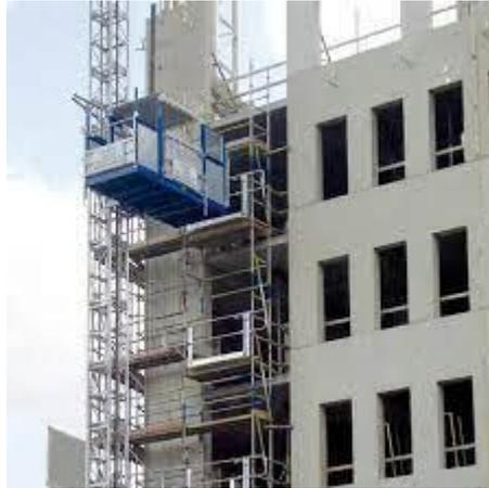
d- Monte-charge ou monte matériaux est un équipement mobile à déplacement verticale, ou incliné, destiné pour le transport inter-étages des outillages, des personnels et des matériaux.
