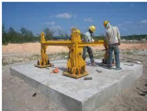
D'un pied de scellement (grues fixes) ou d'un châssis de roulement (grues roulantes), d'un mat ou tour (structure métallique de section carrée) supportant la flèche.
