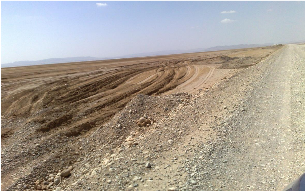
Photo 6: Remblai sur sol compressible: Remblai traversant la Sebkhia du Chott El Hodna
