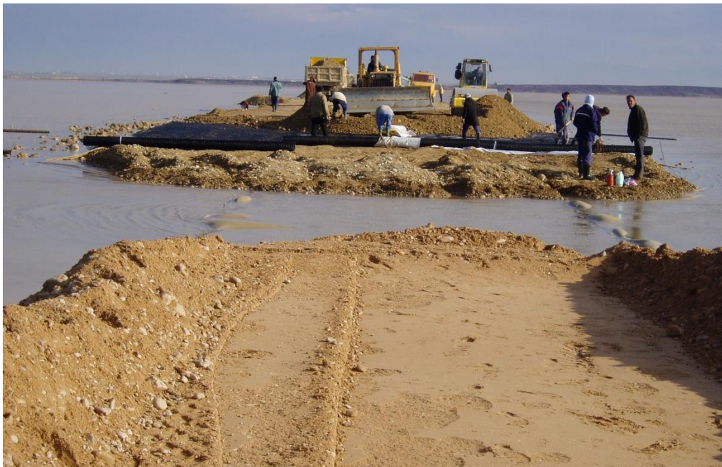
Photo 7: Jonction des deux bouses du remblai traversant la Sebkhia du Chott El Hodna
