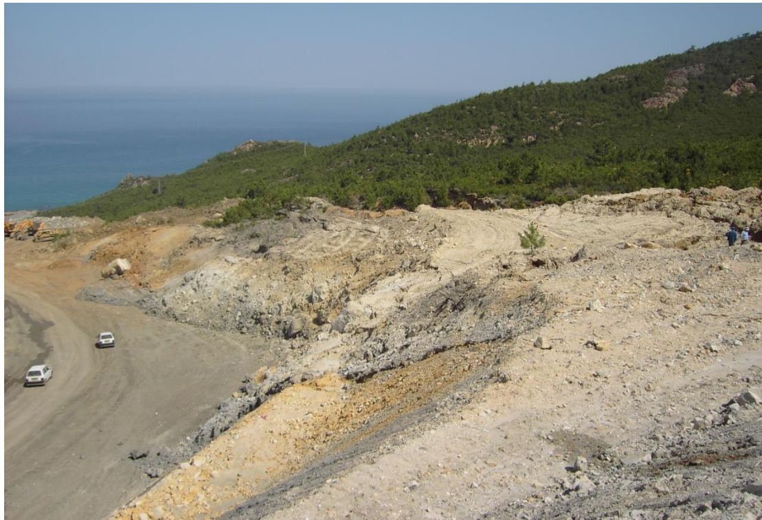
Photo 2: Glissement causé par les travaux de terrassement (Evitement de Jijel 2008)
