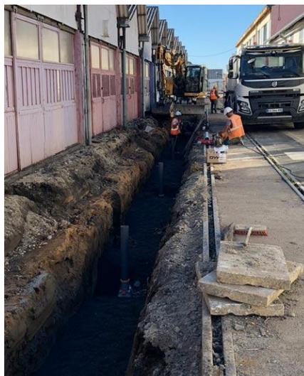
Les terrassements sont effectués par des pelles équipées de système de guidage. Les poses sont effectuées au laser d'alignement. Les réseaux posés sont inspectés et contrôlés par des équipes
