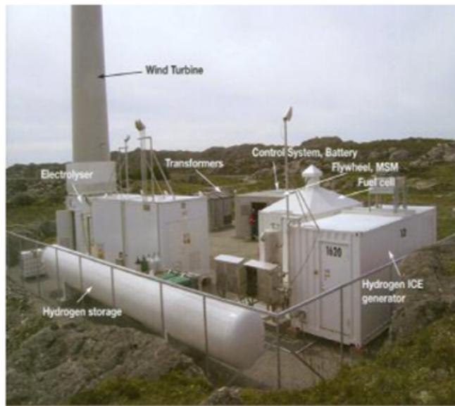
Dispositif du projet UTSIRA, source HYDRO
