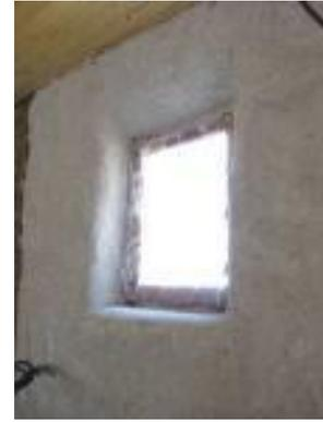
**Photo 4.6:** Enduit au plâtre gros
