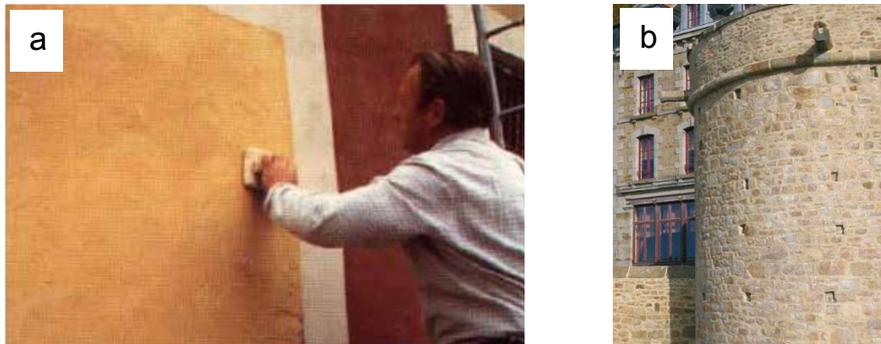
**Photo 4.4:** a. Enduit extérieur; b. Rejointement en NHL 3,5
