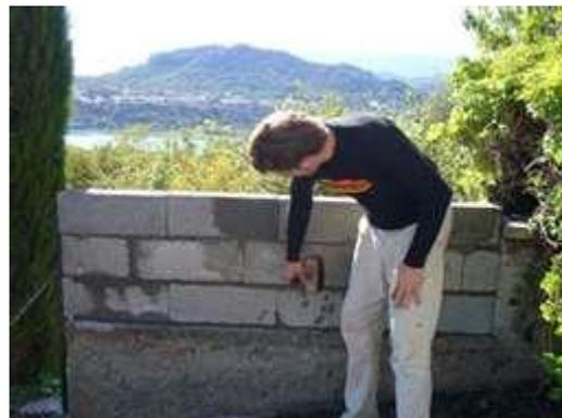
**Figure 6.2:** Réalisation d'un mur en utilisant du mortier dans les joints
