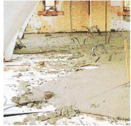
Béton de polystyrène en chape isolante
