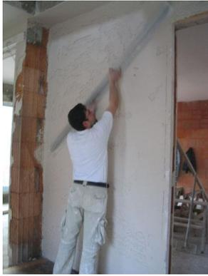
**Photo 4.5:** Enduit intérieur au plâtre
