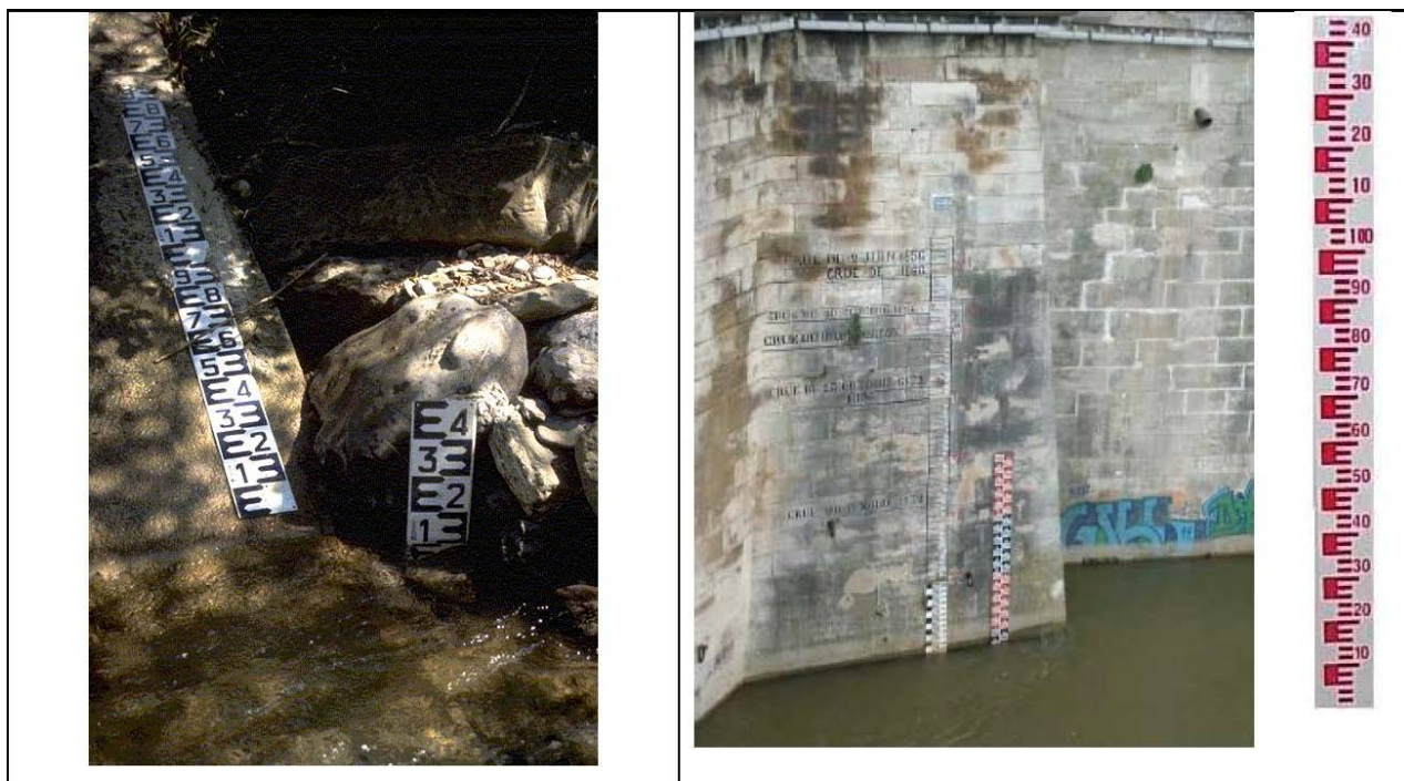
Figure 10 : Exemples d'échelle limnimétrique
