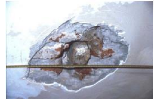
Fig 22: Résonateur du dôme de la mosquée Sultan Ahmed (Source: Kayili, M. (2005))
