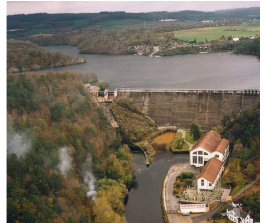
Crédits : Barrage de Guerlédan (22), EDF
