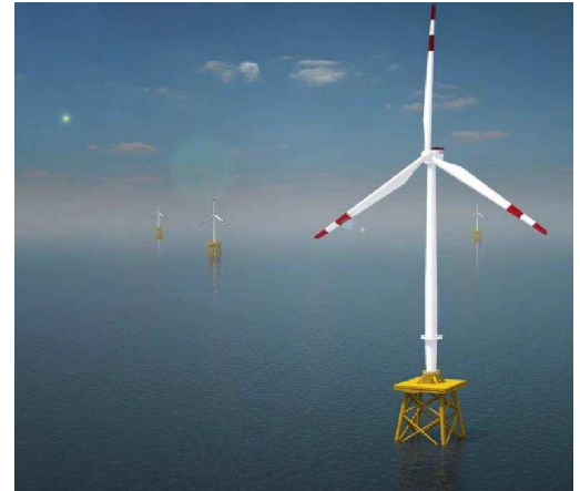
Crédits : Projet de ferme de St-Brieuc (22), Iberdrola
