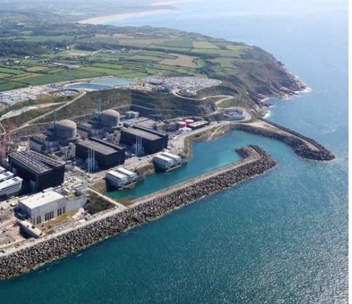
Crédits : Centrale de Flamanville (50), EDF
