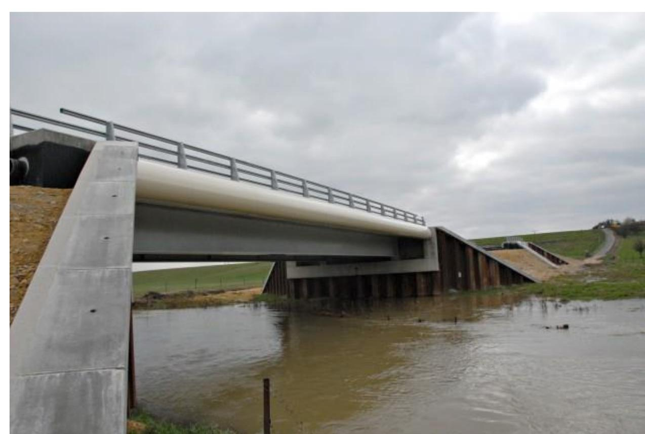
La corniche est un élément de superstructure, destinée à dévier, parer et protéger le bord extérieur d'une dalle de pont.
